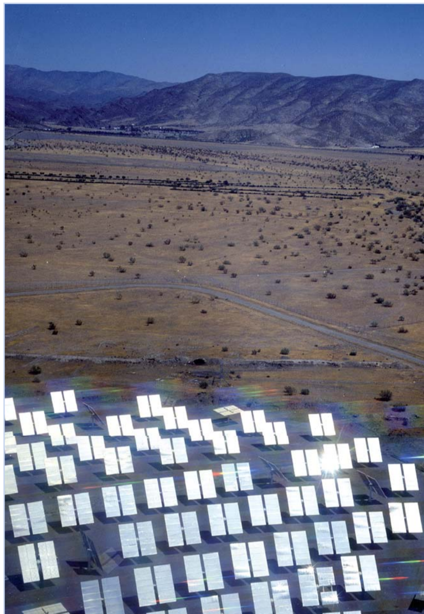
Los heliostatos reflejan y dirigen la radiación solar hacia un punto de concentración para alcanzar altas temperaturas
